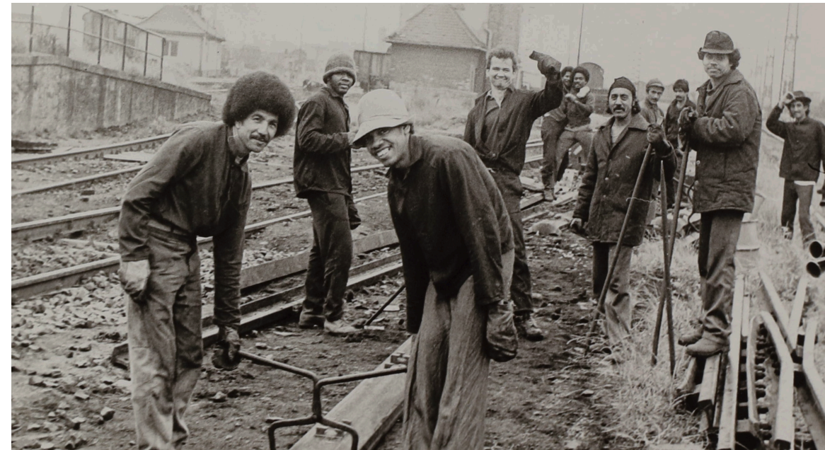
↑ Mario Agustín Figueredo González' Arbeitsgruppe bei Gleisarbeiten zwischen Halle (Saale) und Bitterfeld, ca. 1986. Sammlung Deutsches Auswandererhaus, Schenkung Mario Agustín Figueredo González
